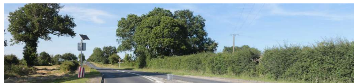
Photo 114 : RD938 – La profondeur des vues dépend de la trame végétale
